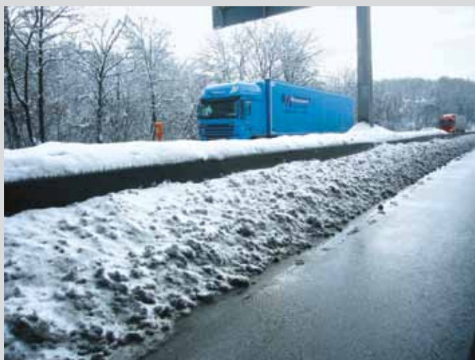
Fig. 12: mur de protection de la berne centrale en béton, couvert de neige, sur l'A 46
