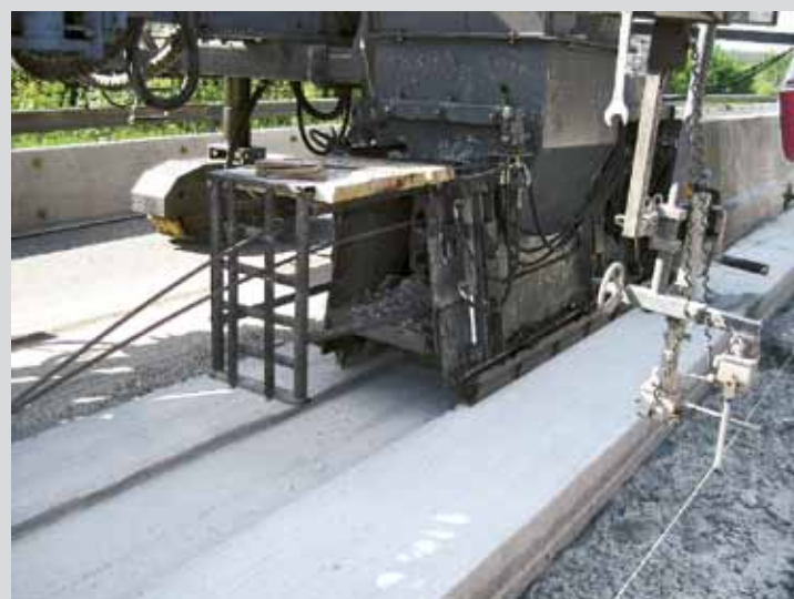
Fig. 8: construction d'un mur en béton ancré dans le sol
