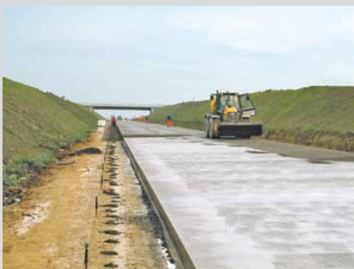
Brossage de la surface en béton lavé
