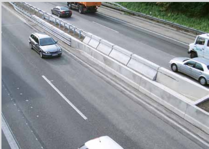
Fig. 3. Raccordement entre deux systèmes
