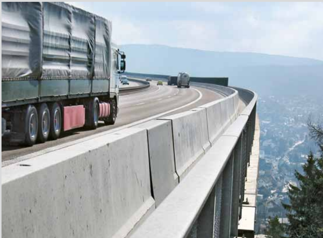
Fig. 1. Mur de sécurité sur un pont
