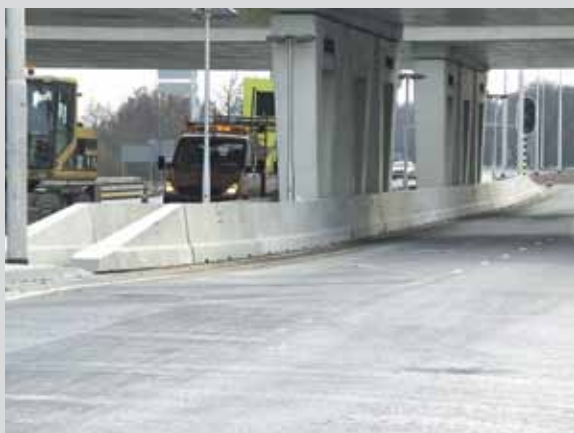
Fig. 10: dispositif en béton protégeant des piles de pont
