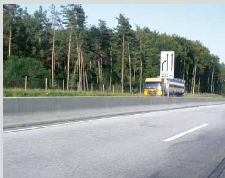
Fig. 6: mur de protection en béton de profil «New-Jersey»
