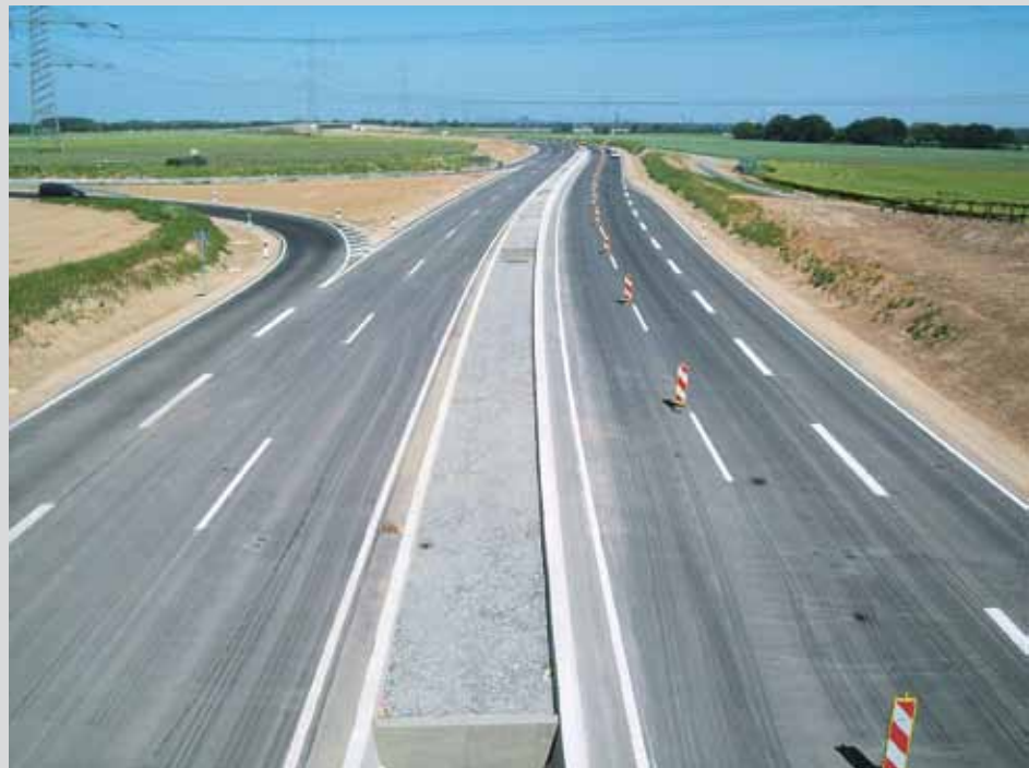
Fig. 11: berne centrale non végétalisée
