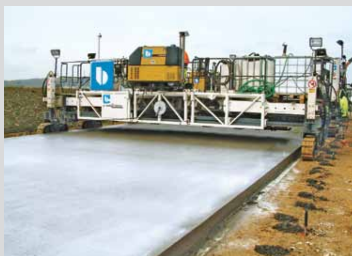
Vaporisation d'un produit de cure liquide
