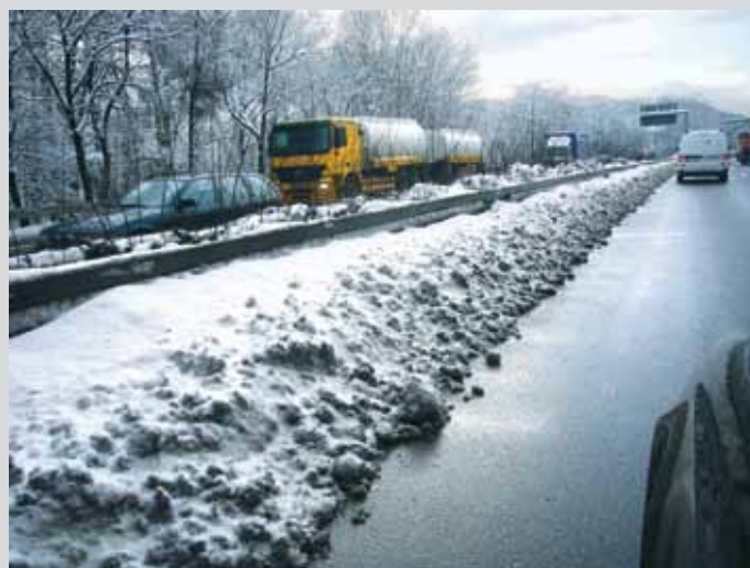
Fig. 13: glissière de sécurité métallique d'une berne centrale, couverte de neige, sur l'A 46
