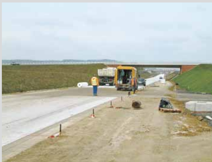
Géotextile sur couche de support stabilisée au liant hydraulique
