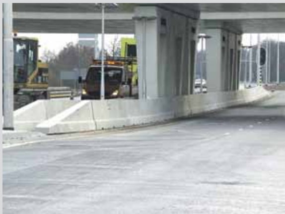
Bild 10: Schutzeinrichtung aus Beton an Brückenpfeilern
