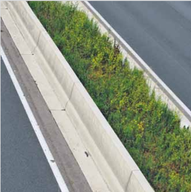
Bild 5: Betonschutzwand mit Step-Profil
