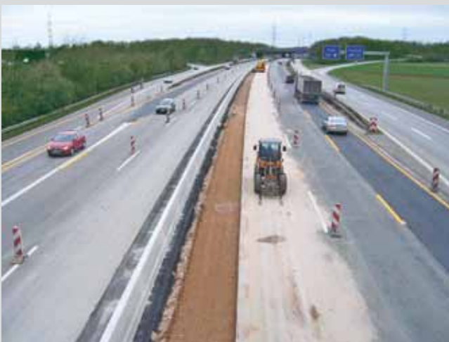
Bild 7: Bau einer frei aufgestellten Betonschutzwand
