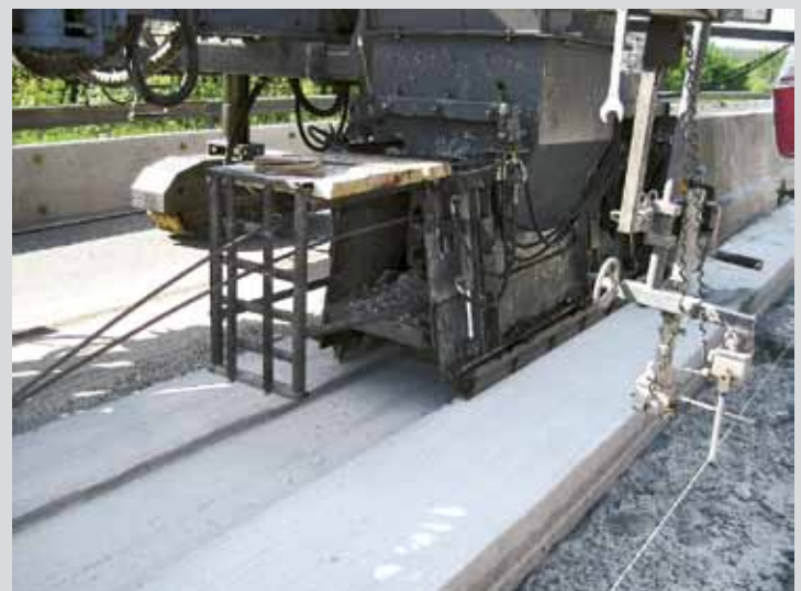
Bild 8: Bau einer eingespannten Betonschutzwand
