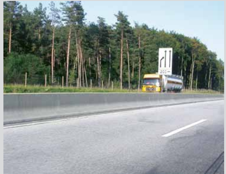
Bild 6: Betonschutzwand mit New-Jersey-Profil
