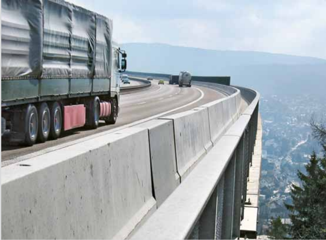
Bild 1: Absturzsicherung auf Brücken
