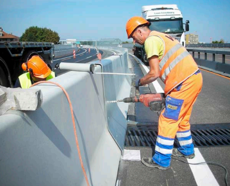
Die Stahlhaube wird an der Dilatation montiert. (Bild: Sacac)
